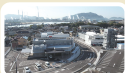
新南陽総合支所 新庁舎完成
